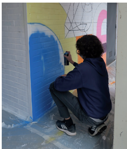
Travaux de peinture dans les halls
