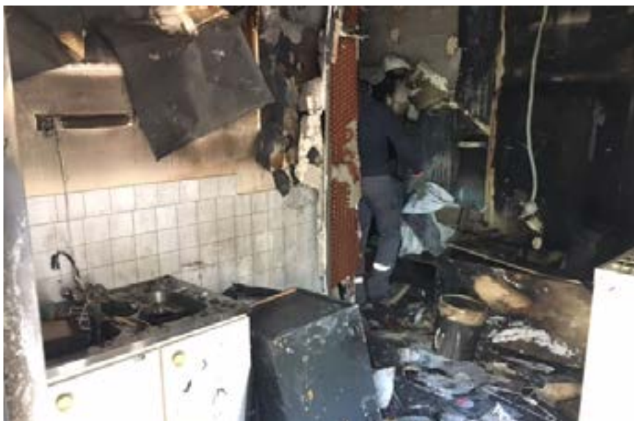
Incendie causé par une friteuse
